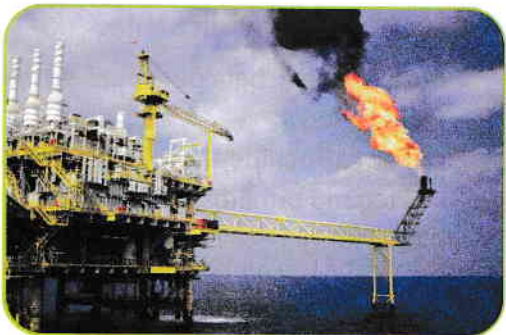
Fig. 3. Platformă de extracție a gazelor naturale
